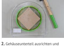
2. Gehäuseunterteil ausrichten und mit vier Nägel befestigen. (Nägel dürfen nur soweit eingeschlagen werden, bis diese bündig auf dem Gehäuseunterteil aufliegen)
