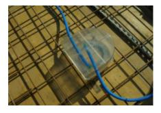
**4.** Rohrverbindungen erstellen. (Rohreinführungen vorsichtig ausbrechen)
